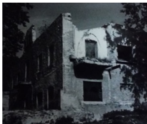
[Fig.18] Ca n'Oller pràcticament enderrocada, inicis dels anys vuitanta. Fundació Cultural Montcada.
