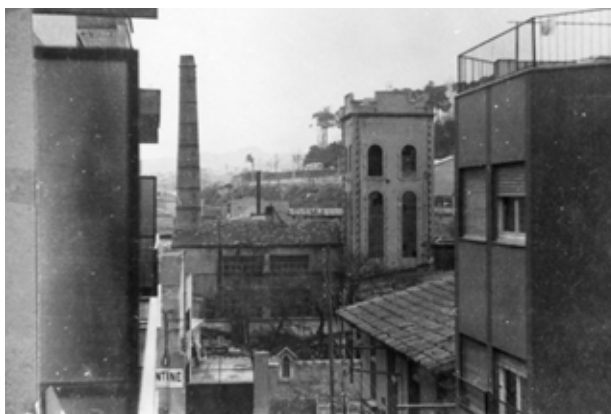
[Fig.41]: la xemeneia i les finestres allargades de la torre. Fundació Cultural Montcada.
