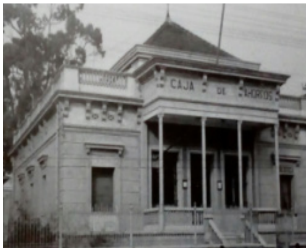
[Fig. 26] Caixa Sabadell, antiga Torre Vives. Fundació Cultural Montcada.
