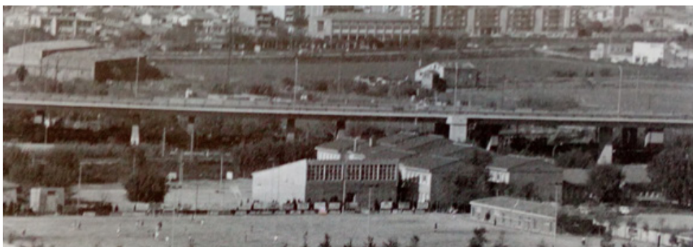
[Fig.42] Fàbrica de Ca n'Armengol modificada per la calderia de Levivier Ibérica. Fundació Cultural Montcada.
